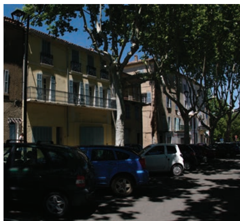
Front bâti ancien à l'ouest
