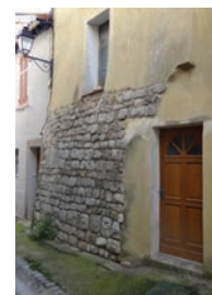
Construction sur enceinte
