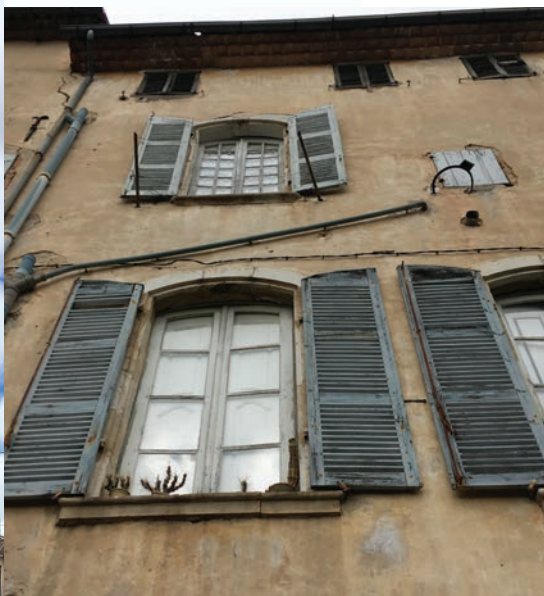
Evolution XVIIIe s. associant châssis à la française à petits carreaux et châssis remanié au XIXe par suppression partielle des petits bois.
