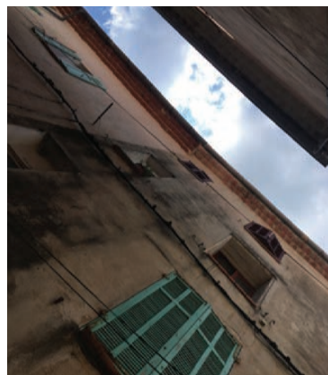
Système mixte : génoise et corniche à denticules
