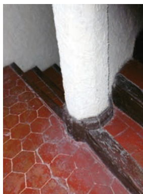
Escaliers à noyaux
