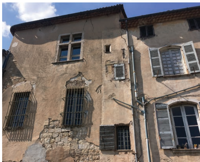
Façade urbaine comprenant une baie début XVIIe s.
