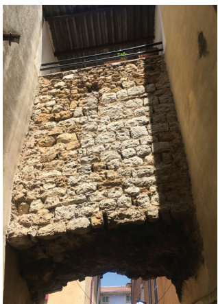
Porte Saint-Nicolas dans l'enceinte XIII : la porte percée ultérieurement, permet une lecture de la structure de l'enceinte
