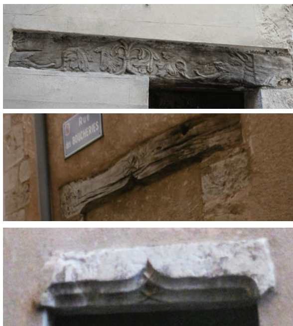
Linteaux bois (traverse de la Boucherie) et pierre (gothique tardif - Maison Coquelin).
