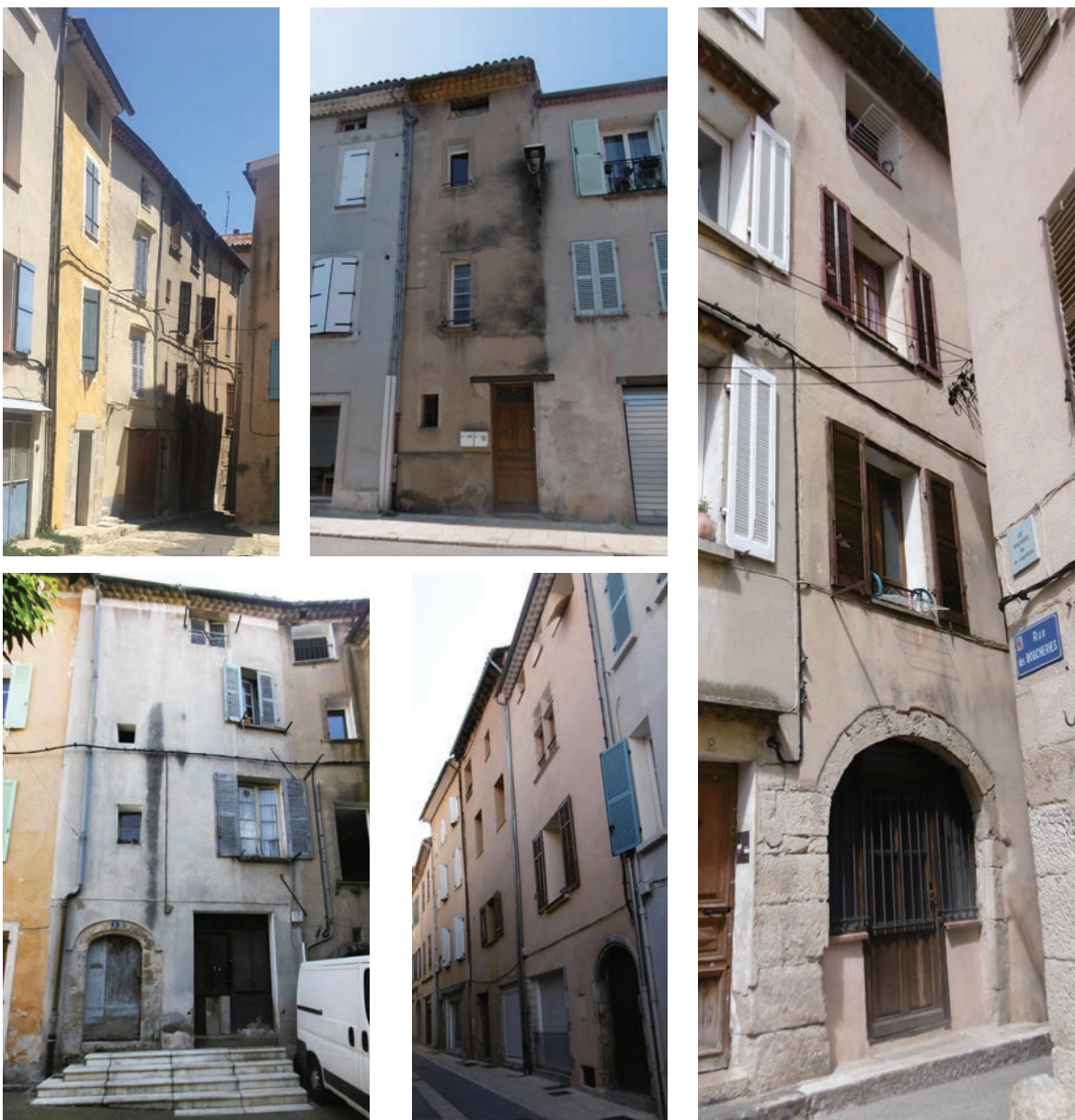
Exemples de maisons de bourgs représentatives dans le centre ancien de Brignoles.
