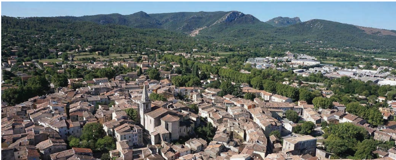
L'Eglise Saint-Sauveur domine le Centre historique de Brignoles. Une église est attestée dès le 12e s. Le portail est protégé IMH
