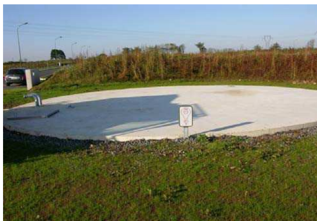
Réserve d'eau enterrée
