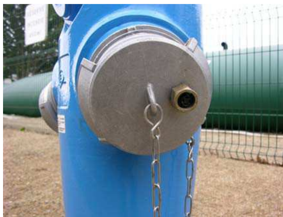
Poteau d'aspiration de 150 mm muni d'un Airclap
